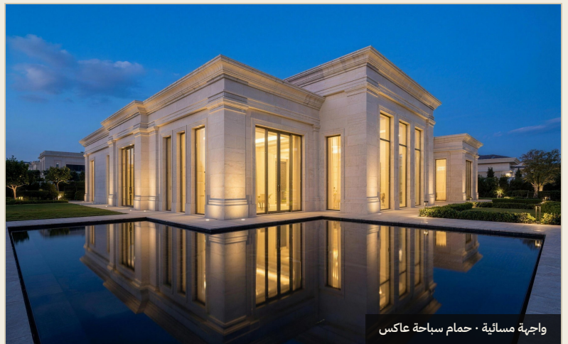
فيلا كسوة مُغلّقة - كرانيش وأنصاف أعمدة
